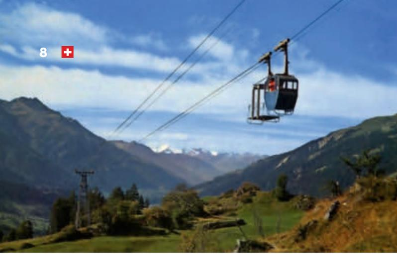
Die ursprüngliche *Kleinseilbahn Fürgangen – Bellwald* (1956 – 1977) wurde mit 4er-Kabinen samt Lastengehänge ausgestattet.
