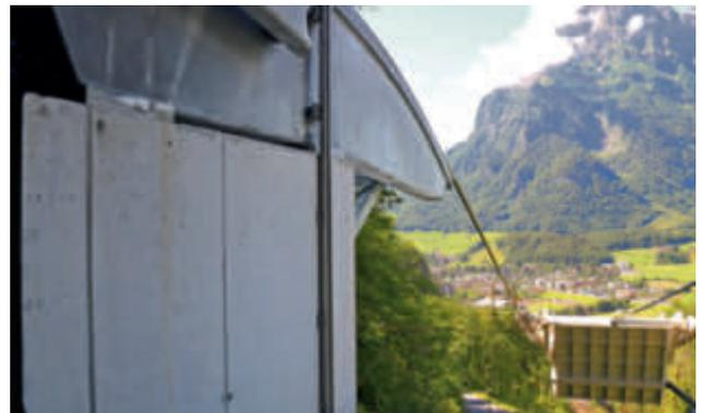
Bergstation: Die Tragseile werden über Sättel schräg nach unten auf die Poller geführt (oben). Während des Befüllungsvorgangs steht das Fahrzeug komplett auf Stahlträgern, um beim Befüllen sicher keine schädlichen Beanspruchungen der Tragseile durch Stöße zu bekommen.
