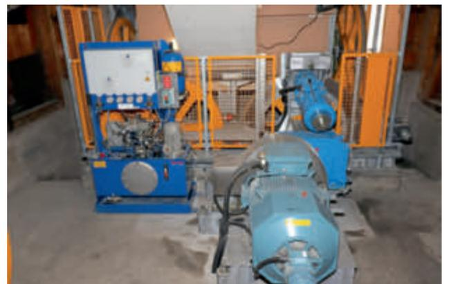
Der neue 55-kW-Antrieb der *Kleinseilbahn Intschi – Arnisee* befindet sich in der Talstation.
