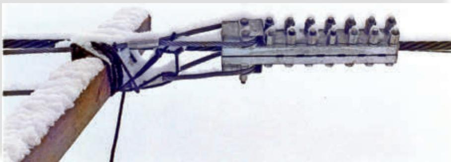
Abb. 2: Auch an einem Querträger des Stationsvorbaus wurde das Förderseil mittels einer Montageklemme gesichert.
