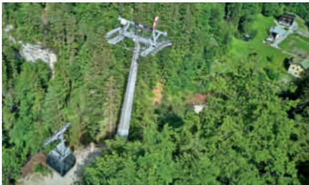
Über die einzige rund 22 m hohe Stütze der neuen *Graseckbahn* laufen die beiden in den Stationen fest verankerten Tragseile sowie das Zugseil in einer Endlosschleife. Die Seilrollen haben einen Durchmesser von 241 mm, ihre Fütterung besteht aus Gummi.
