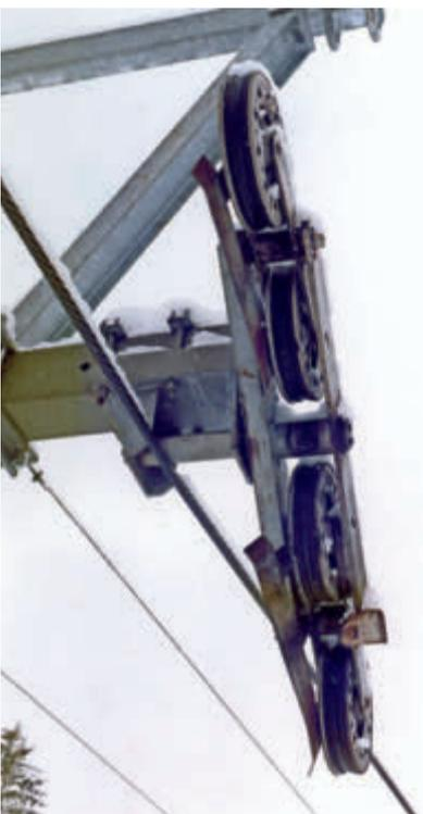
Abb. 5: An der Niederhalte-Rollenbatterie der Stütze 1 entgleiste das Förderseil nach innen.
