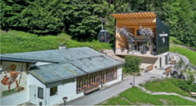
Talstation der *Graseckbahn*: Der kompakte Antrieb des Seilbahnsystems von Inauen-Schätti benötigt nur sehr wenig Platz. Sowohl die Tal- als auch die Bergstation der neuen *Graseckbahn* wurden auf zwei Betonstehern errichtet.
