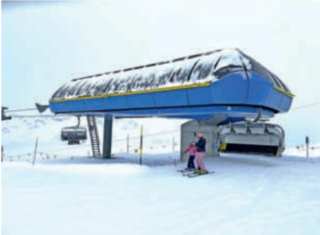
Der beliebte FIS-Lift im Skigebiet Corviglia bei St. Moritz wird retrofit gemacht mit einem *Leitner DirectDrive*, einer neuen Steuerung und mit überarbeiteten Haubensesseln.
