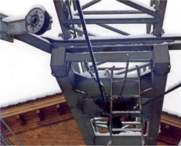
Abb. 3: Einige Bauteile der Stationsstruktur wurden durch das Förderseil verbogen.
