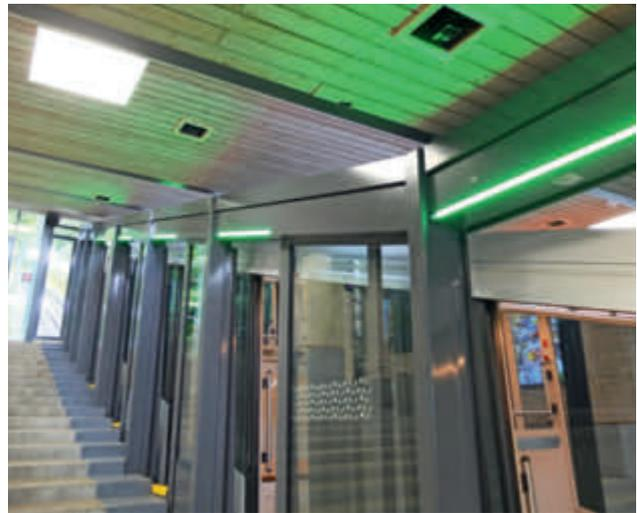
Über den Einstiegstüren der Fahrzeuge sind in der Decke 3D-Sensoren installiert zur Zählung der zugestiegenen Passagiere.
