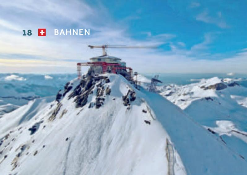
Beim Generationenprojekt *Schilthornbahn 20XX* setzt die Betreiberin unter anderem auf den Bau von *Funifors* sowie einer der steilsten Pendelbahnen der Welt mit einer maximalen Steigung von 160 %.
