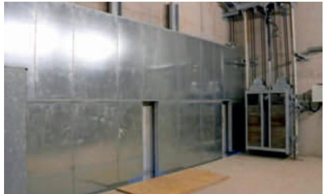
Die Bergstation (oben) wurde so integriert, dass von der Talsohle nur die Einfahrtsöffnung der Materialseilbahn sichtbar ist. Als zusätzliche Lärmschutzmaßnahme wurde eine 5 t schwere, hochfahrbare Schallschutzwand (unten) installiert, die sich nur öffnet, wenn die Fahrzeugmulde ein- und ausfährt.
