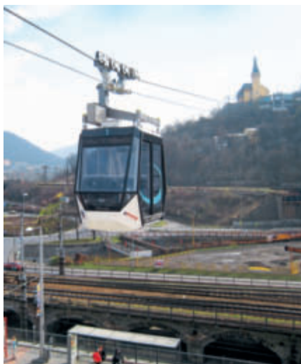
Le téléphérique de « Vetruse » survole plusieurs routes et lignes de chemin de fer.
