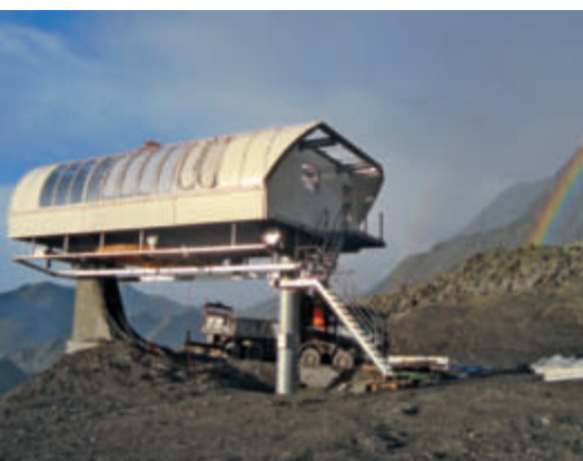
Montage de la station aval du Funitel de Val Thorens
