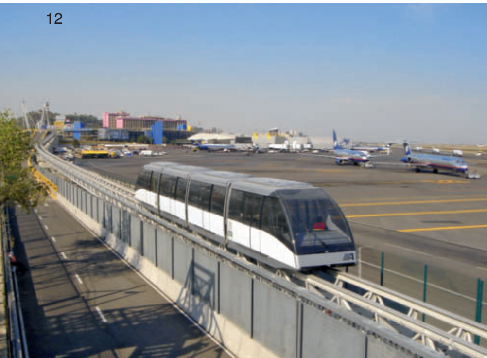
Fig. 12 : Le Cable Liner Shuttle de l'aéroport de Mexico City /Mexique
